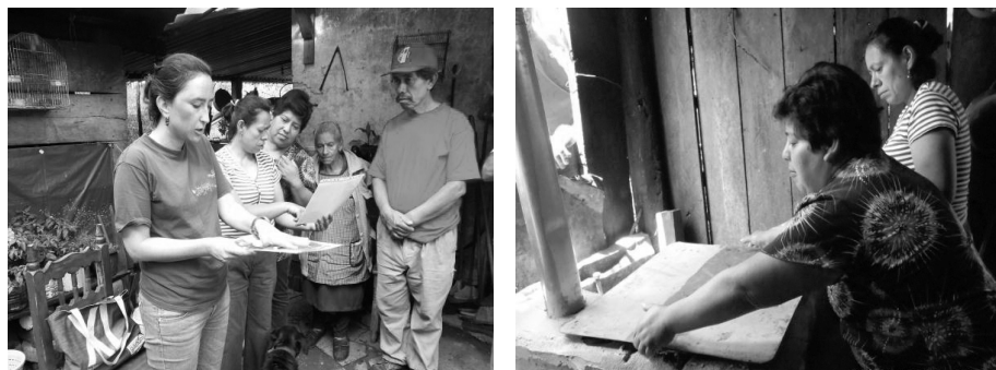
Fotos 11 y 12. Organizándonos y trabajando en la construcción de la primera estufa en casa de Doña Ángela y Doña Candelaria (Krystyna Paradowska, 2015).
